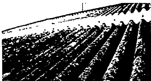
Fig.1 - Cobertura de fibrocimento
